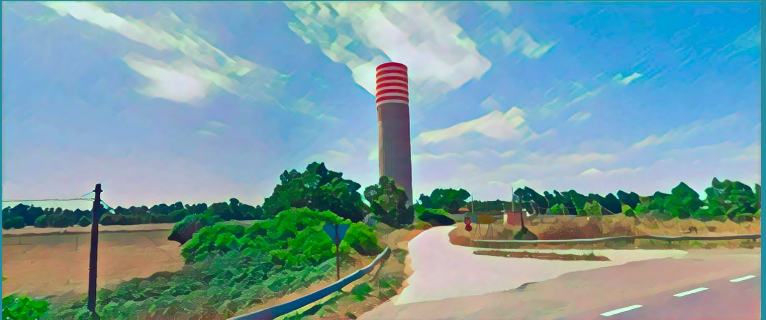
Figura 11. Torrino piezometrico dell'impianto di sollevamento di Sinistra Leni
